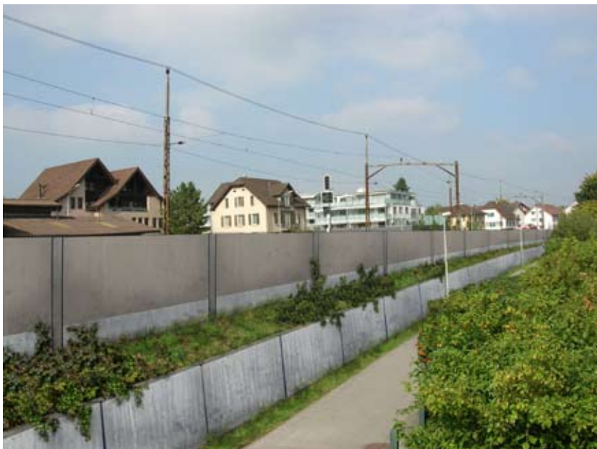
Fotomontage Stützmauer und Lärmschutzwand Seemattstrasse.
